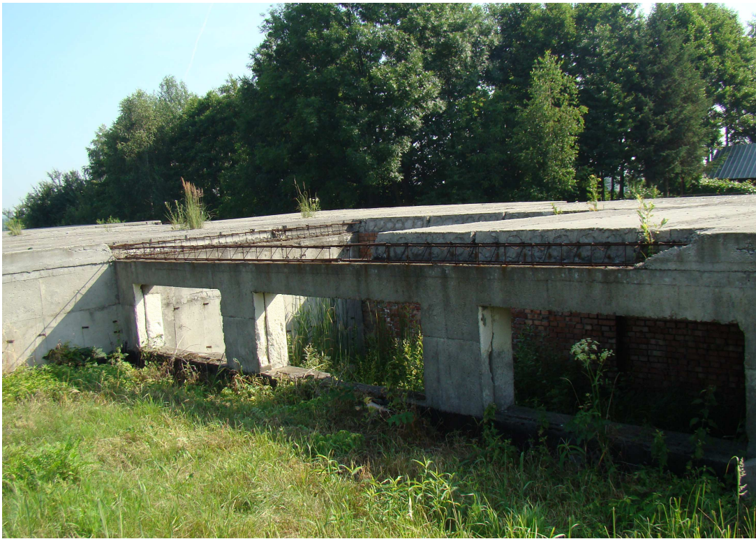
Fot. 11. Widok stropu piwnic.
